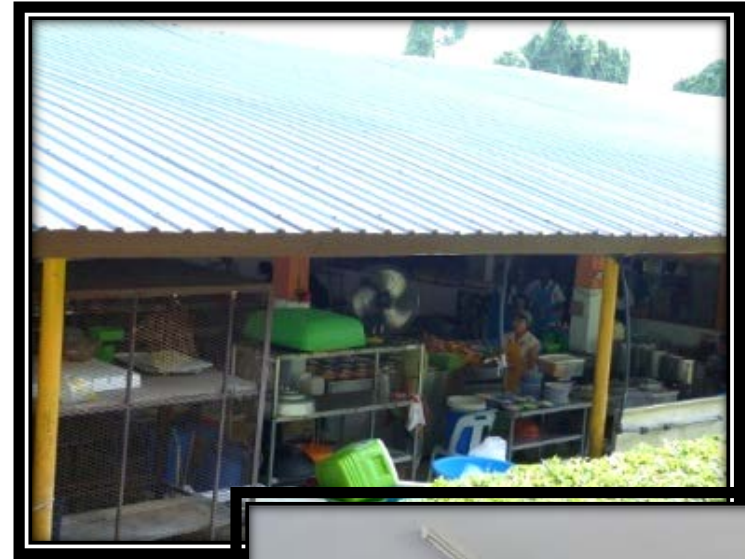
食堂屋顶 Bumbung Dan Siling Kantin
