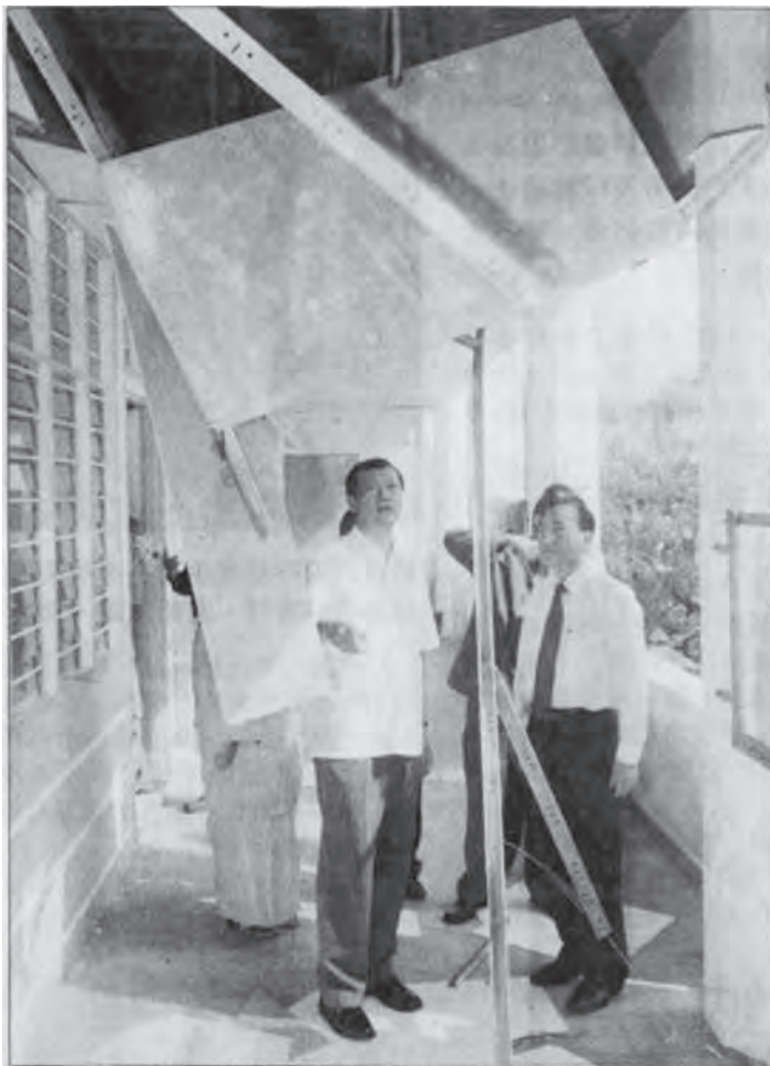
国、韩春锦。 大片天花板坠落地面的原因，相信是因为装修工程出现技术性问题的原因。左起卢诚
