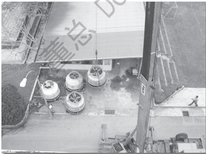
▲ 卸除天台中央冷气槽工程。
