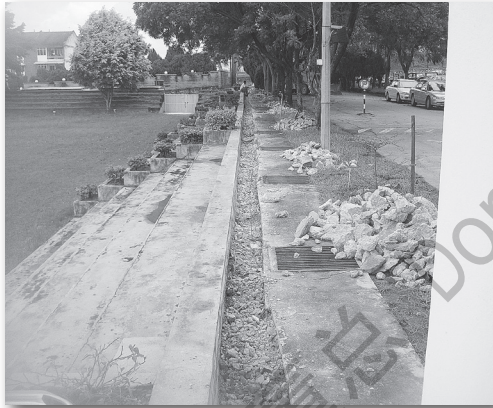
▲ 户外消防水管汰换工程。
