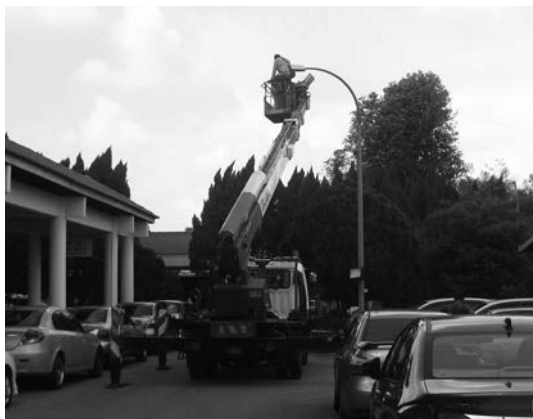
维修行政楼旁路灯。
